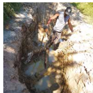
La réparation de l'alimentation des fontaines de Travers a été le principal chantier de l'été.
