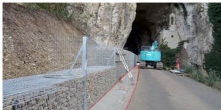
La sécurisation du Front-Rocheux se poursuit. De mi-janvier à mi-février, c'est toute l'entrée des Grottes qui a été sécurisée. Un décaissement de 220 m<sup>3</sup> de terre a été réalisé, de même que la pose d'un mur en Gabion.
