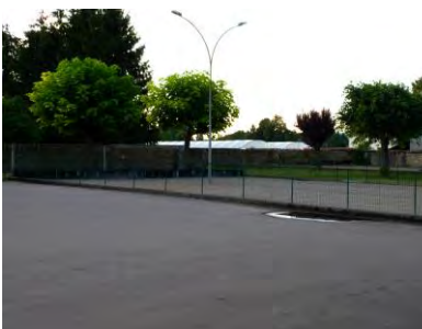
Photos ci-contre : mur de clôture autour du jardin public
