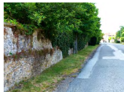
Le mur d'enceinte du parc du château route de Crémieu
