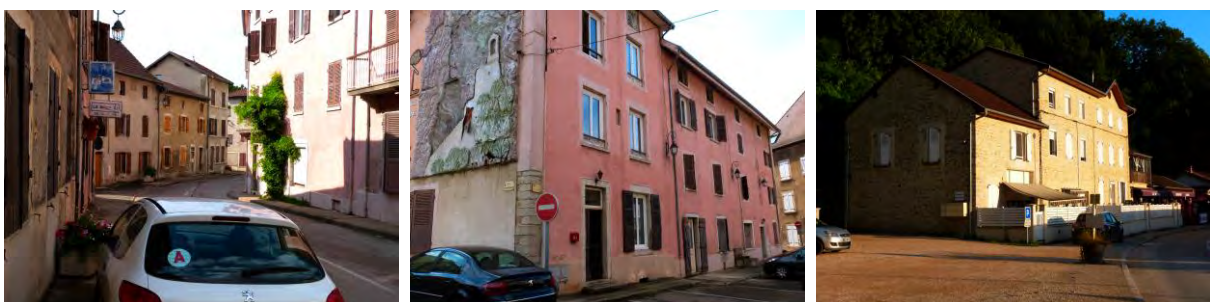
Densité de l'habitat au niveau des fronts bâtis : immeuble de 24 logements donnant sur la rue principale (photo de gauche) et la rue de la Coubardière à l'arrière
