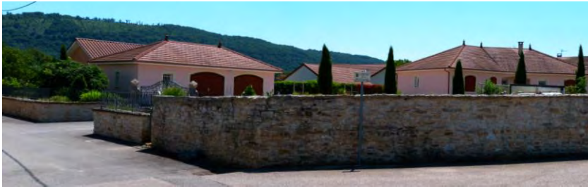
Constructions nouvelles implantées à l'arrière d'un mur ancien en pierre, qui est conservé
