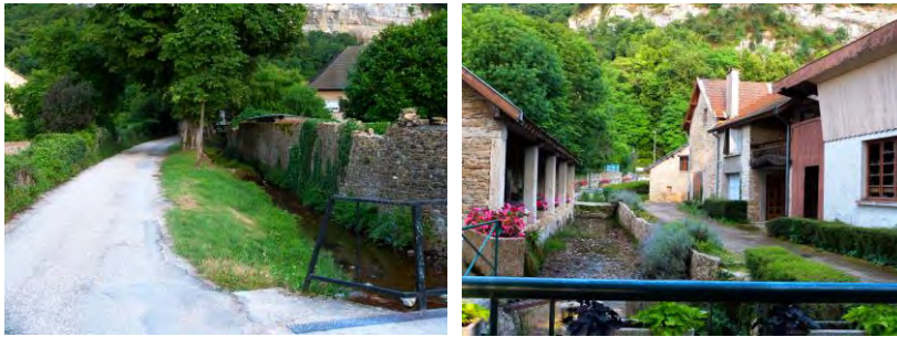
Mur ancien et lavoir le long d'un ruisseau au nord du village
