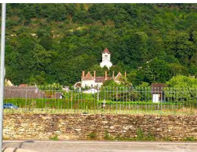
Photos ci-contre : -A gauche : mur de pierre le long du chemin de Travers -A droite : mur de pierre le long du chemin de Salette
