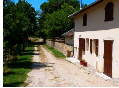
Mur le long d'un chemin adjacent à la RD65h
