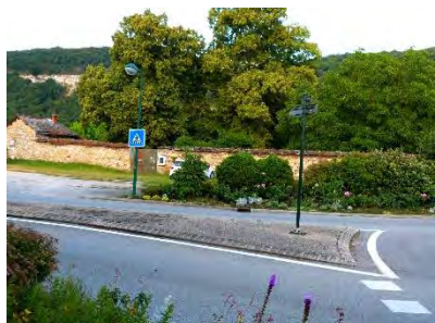
Photos ci-contre : mur de pierre le long de la RD65i
