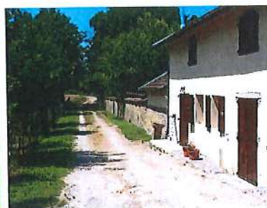
Mur le long d'un chemin adjacent à la RD65h
