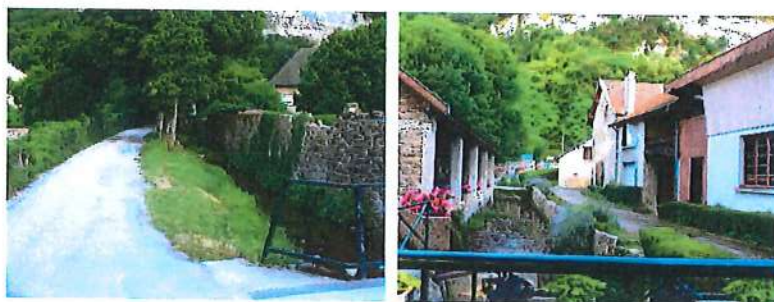
Mur ancien et lavoir le long d'un ruisseau au nord du village
