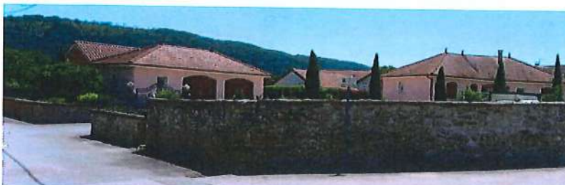
Constructions nouvelles implantées à l'arrière d'un mur ancien en pierre, qui est conservé
