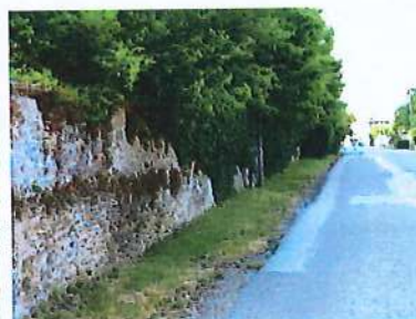
Le mur d'enceinte du parc du château route de Crémieu
