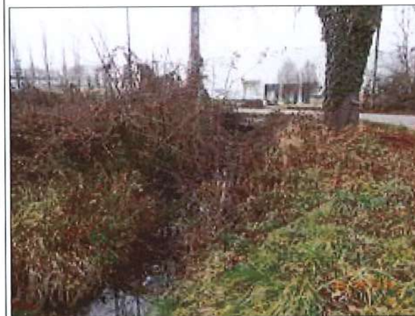
Photo 9 : Pont du ruisseau des Grottes sous la route de Port-Michaud.
