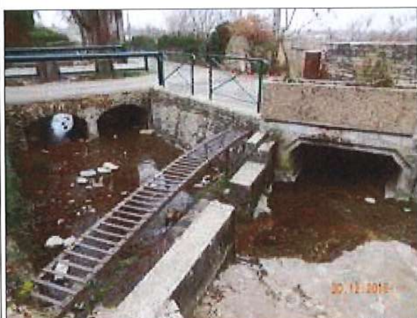
Photo 5 : Aménagement du ruisseau des Grottes à l'aval du lavoir. A droite de la photo le dalot initiant le canal de dérivation.
