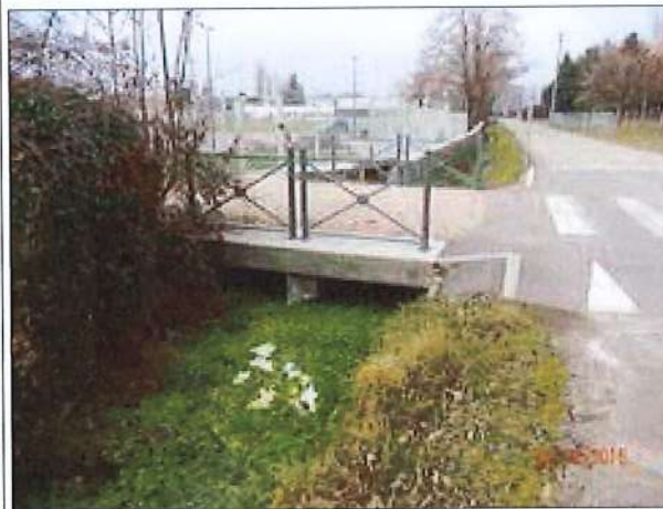
Photo 8 : Ponceau du ruisseau des Grottes à l'aval de la RD65i.
