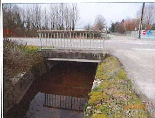
Photo 7 : Pont du ruisseau des Grottes au niveau de la RD65i.
