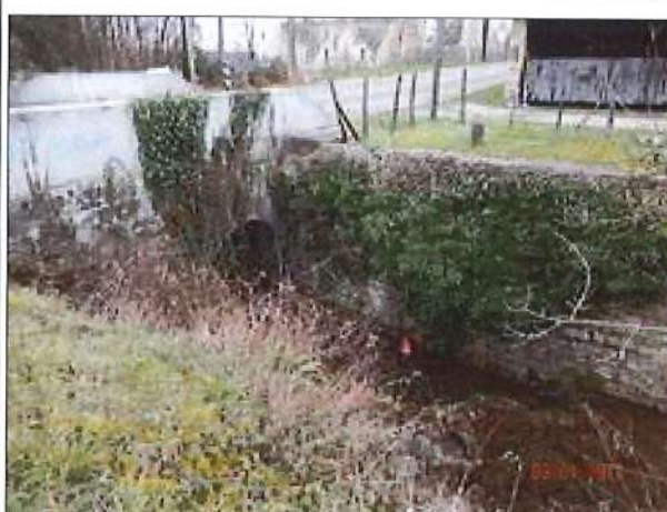
Photo 12 : Passage du ruisseau d'Amblérieu sous la RD65.
