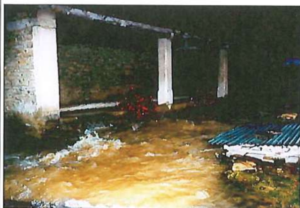
Photo 1 : Débordement du ruisseau des Grottes au niveau du lavoir le 12 octobre 1988 (source: Le Balmolan - 2000).
