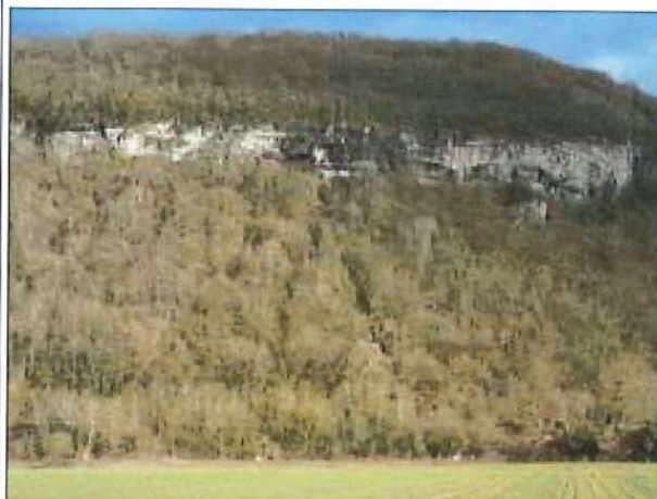
Photo 13 : Chute de blocs du 31 janvier 2017 au Nord du bourg de La Balme. Les deux blocs principaux ont laissé deux traces bien visibles dans la forêt.
