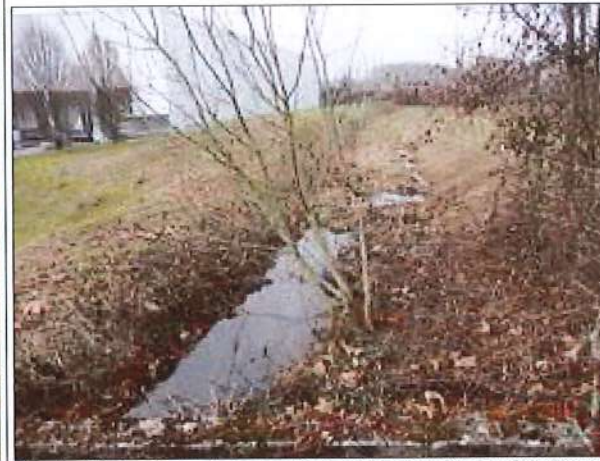
Photo 10 : Levée de terre en rive gauche du ruisseau des Grottes à l'aval de la route de Port-Michaud.
