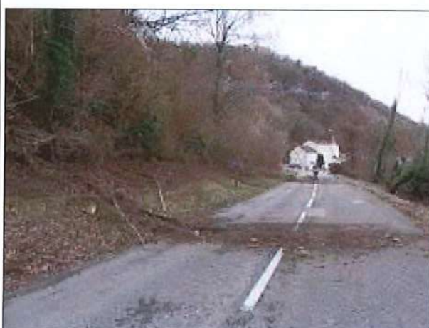
Photo 15 : Impacts sur la RD65 lors de l'évènement du 31 janvier 2017.
