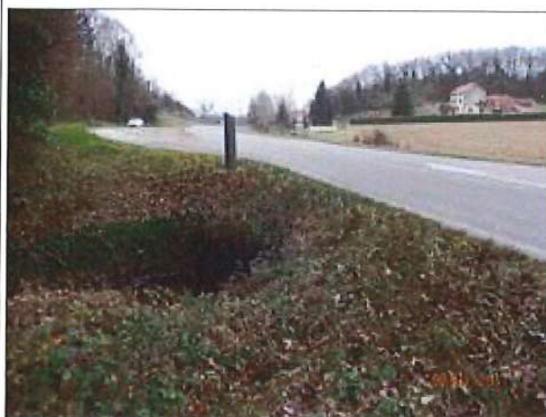
Photo 11 : Passage du ruisseau d'Amblérieu sous la RD52c.
